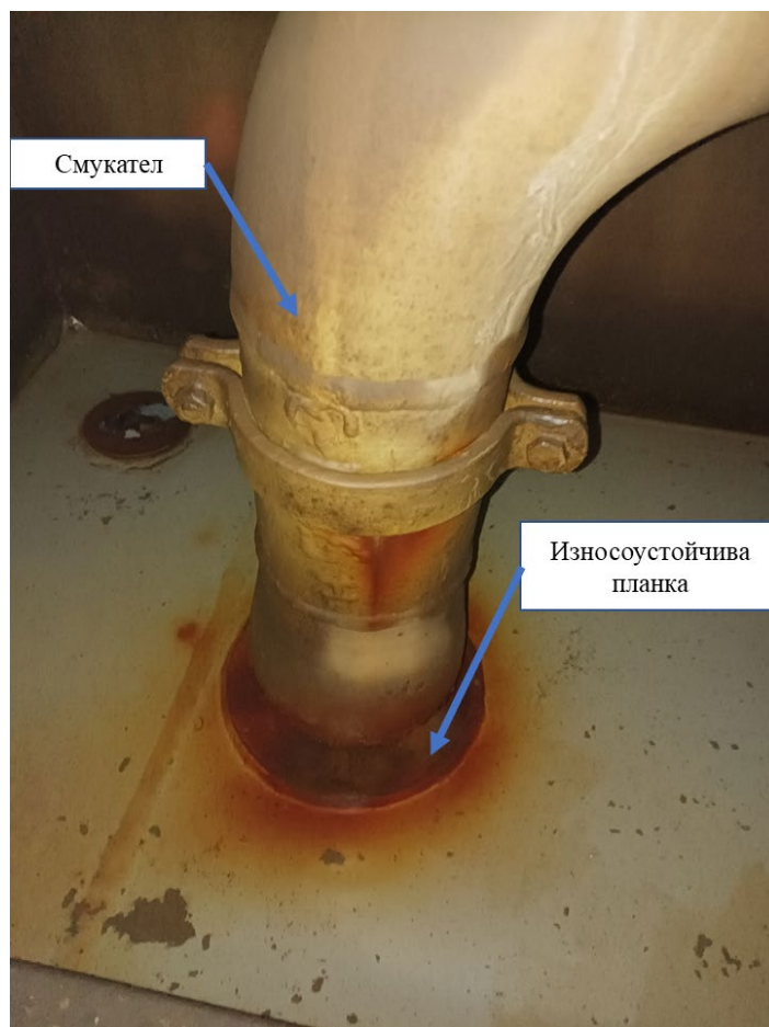
Фиг.1. Монтаж на износоустойчива планка[7]
